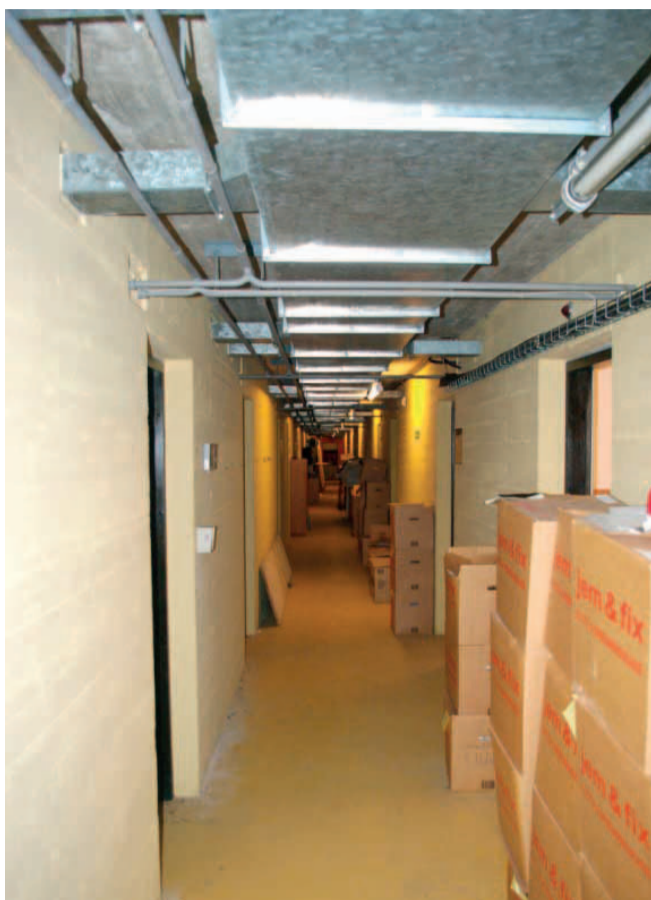
Fordelingsgangen i den store kommandocentral under skolen. Haderslev Katedralskole overtog bunkeren i 2007 og bruger den i dag som depot. Foto: Martin Pagh, Jysk Koldkrigsforening.
