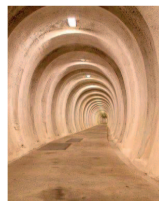
Regeringsanlægget Regan Vest, som er placeret i Rold Skov, er dybt begravet 60 meter under jorden. Konstruktionen indeholder næsten to kilometer gange, tunneler og skakter samt 160 rum til 350 personer. Foto: Karsten Pedersen www.reganvest.dk
