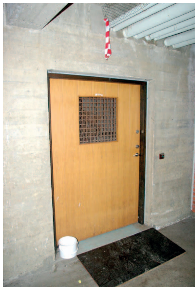
Diskret indgangsdør til bunkeren under Haderslev Katedralskole. Bag døren er der gas- og tryksikre ståldøre. Foto: Martin Pagh, Jysk Koldkrigsforening.
