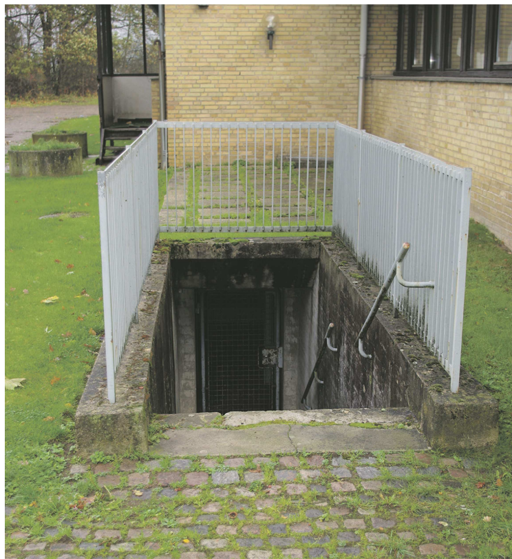
Nedgangen til bunkeren, der er på ca. 150 m 2 .
