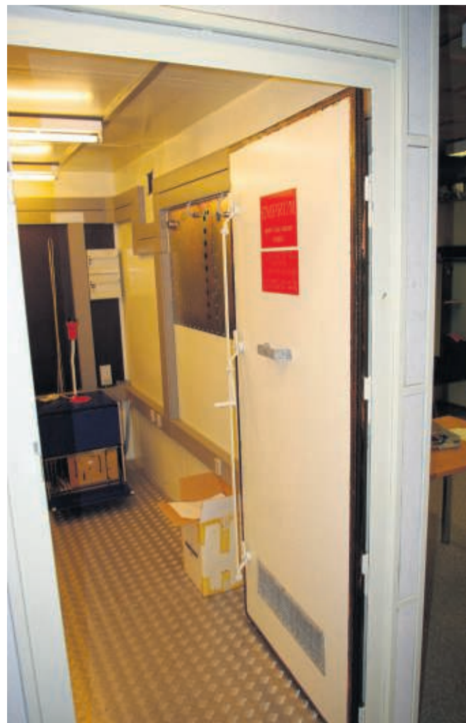
Bunkeren har – som en af få kommunale kommandocentraler et EMP sikkert rum som er beskyttet mod stråling fra atombomber. Foto: Jysk koldkrigsforening
